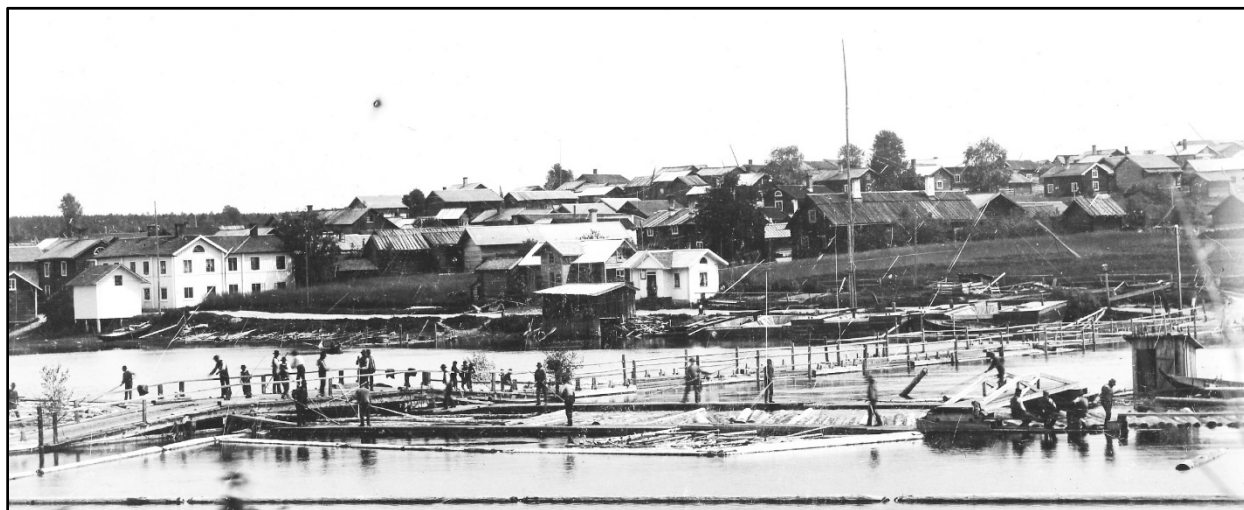
Bild 10. Flottbron sedd från Broåkern mot Noret. Den användes fram till 1896, då en kombinerad landsvägs- och järnvägsbro byggdes intill den nuvarande järnvägsbron. På bilden styr flottningsarbetare timmer förbi en upphöjning av flottbron som leder in i Mora skiljeställe. Den lilla vita stugan i fotots mitt är brostugan. Foto: Hjalmar Klingvall något av åren 1893-1896.
