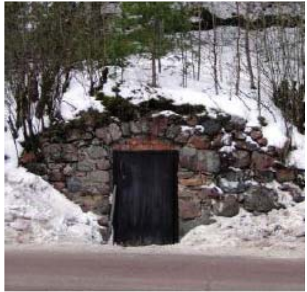
Figur M.2. Jordkällare längs Bonäs norra bygata horisontellt ingrävd i dynfoten, mer vanligt var att jordkällaren grävdes vertikalt ned i den sandrika marken.
