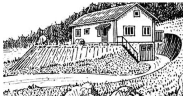
Husval har orsakat onödigt stora markarbeten och utfyllnader.
