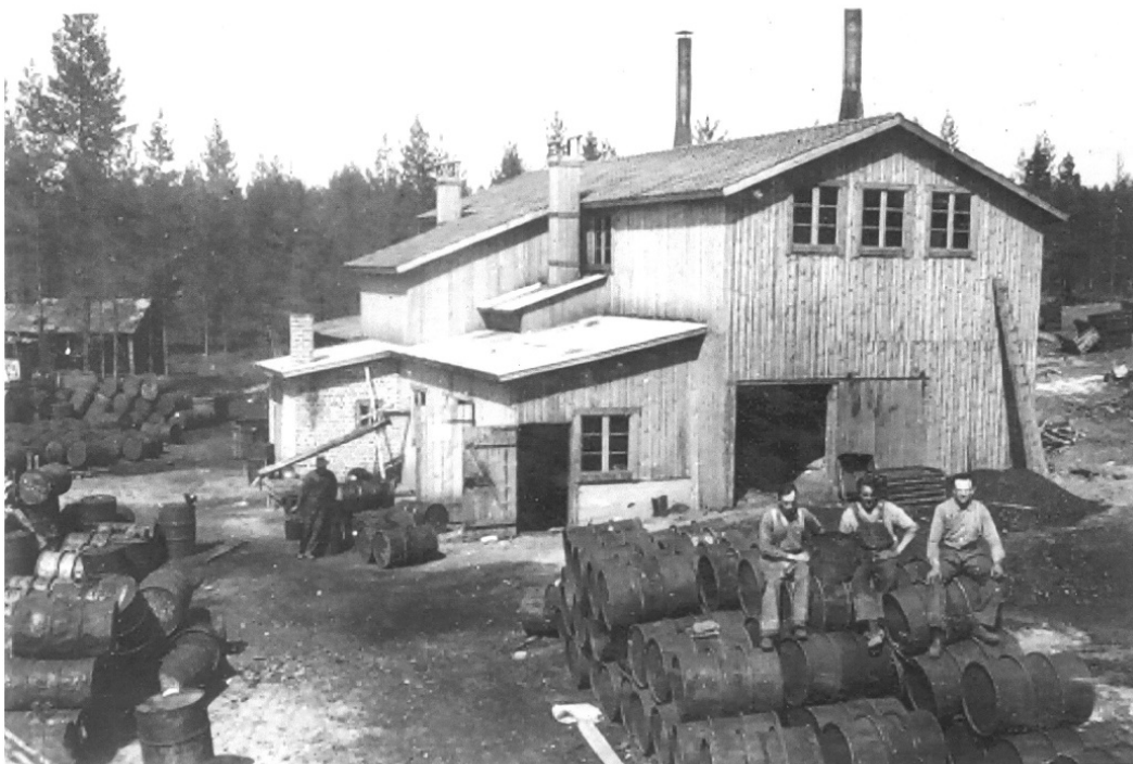
Bild 1. Läde tjärfabrik före bytet av retorter 1944, från 10 m 3 till 3 m 3 . Tjäran togs ut i utbyggnaden med den öppna vänstra dörren, där ett ca 10 cm grovt kopparrör från vardera retort mynnade. Den högre utbyggnaden därbakom, utskjutande till vänster om huvudbyggnaden, var ett kondensatorhus med fyra kondensatorer, som kylde ångan från vardera retort, så att vatten och terpentin blev flytande och tappades i ett träkar. Där uppstod en skiktning, eftersom vattnet är tyngre än terpentin. Ett ca 10 mm grovt glasrör, öppet i båda ändar, doppades i träkaret och prov togs upp för att kontrollera gränsen mellan vatten och terpentin. När lagret av terpentin var tillräckligt djupt östes terpentin upp med hinkar och hölls i behållare. Kylvatten till kondensatorerna pumpades från ån upp till en behållare i kondensatorhuset. Den ensamme mannen till vänster om tjärfabriken är Karl Teodor Jonsson, som kom till Läde i samband järnvägsbygget i slutet av 1890-talet. Hans första fru var en Seljaflicka, och hans andra fru hette Selma och kom från södra Sverige (bild 20). Uppe på tjärtunnorna sitter fr. v. Ernst Lund från Selja, Hjalmarsson från Bonäs samt en okänd person. Det lilla huset i bakgrunden, till vänster om fabriken, ägdes av Johan Sundberg. Fotograferat från sydväst (se bild 14). Fotograf okänd.
