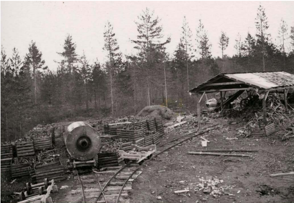
Bild 5. Råls från stubbklippen in mot fabriken (till höger). På den vänstra rålsen ligger en retort som är uttagen för svalning och tömning av kol. Efter tömningen kördes retorten fram till stubbklippen och fylldes med ved. Därefter kördes den in i fabriken igen. Det fanns extra retorter så att man direkt efter uttag kunde köra in en nyfylld retort. Därigenom blev det inga väntetider medan den uttagna retorten svalnade. Foto: Skogsägarnas Olje AB.
