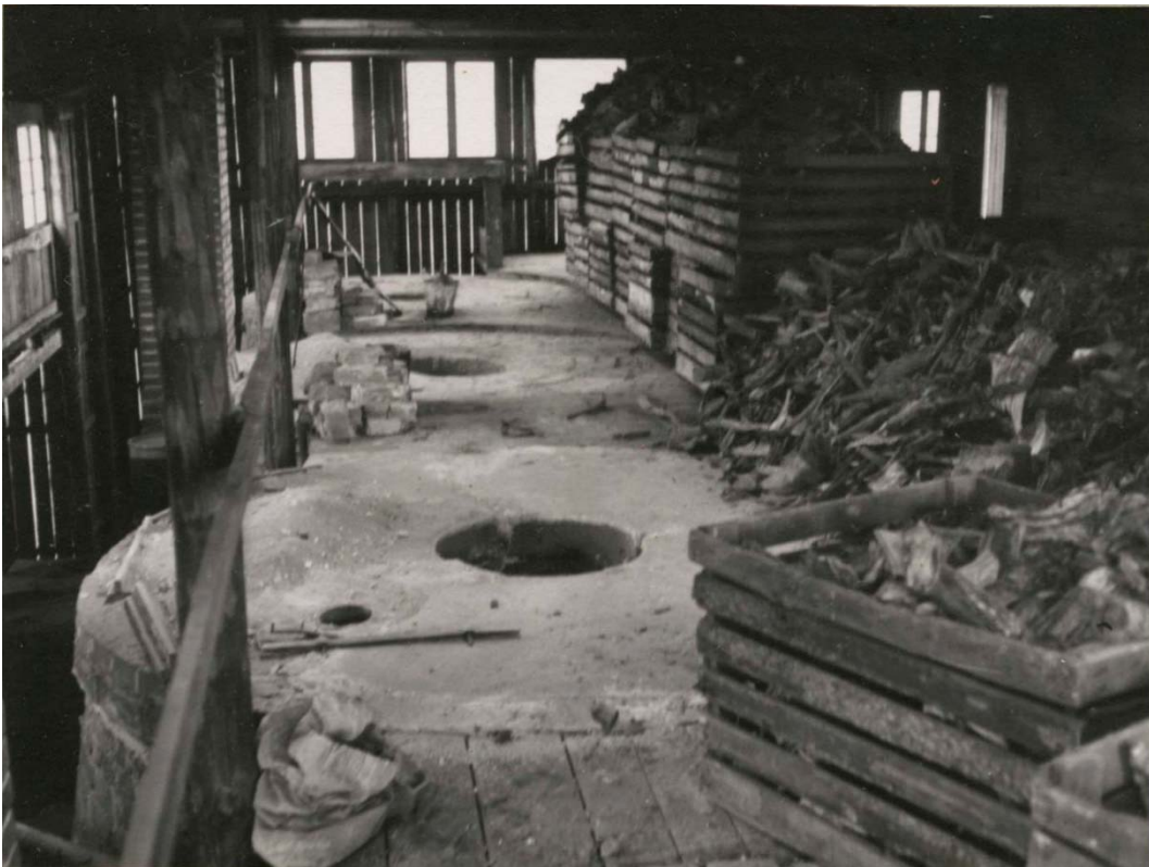
Bild 3. Läde tjärfabrik före bytet av retorter 1944 från 10 m 3 till 3 m 3 . Foto: Skogsägarnas Olje AB
