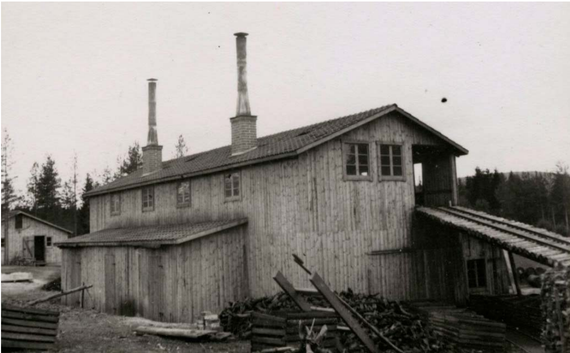
Bild 2. Läde tjärfabrik före bytet av retorter 1944 från 10 m 3 till 3 m 3 . I utbyggnaden till vänster fanns fyra murade vedeldade ugnar med järnluckor. På bryggan med räls kördes stubbveden in efter att ha klippts i stubbklippen (bild 5). Efter ombyggnaden 1944 togs bryggan bort och rälsen gick i markplanet direkt in i fabriken. Då togs även de lyftbara retorterna ut och in via denna räls (bild 5). Fotograferat från nordost (se bild 14). Foto: Skogsägarnas Olje AB
