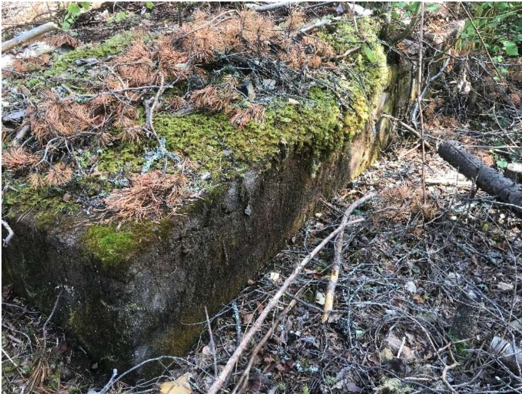
Bild 8. Betongfundament vid Gutdalens tjärfabrik. Foto: Christer Karlsson 2018-07-31
